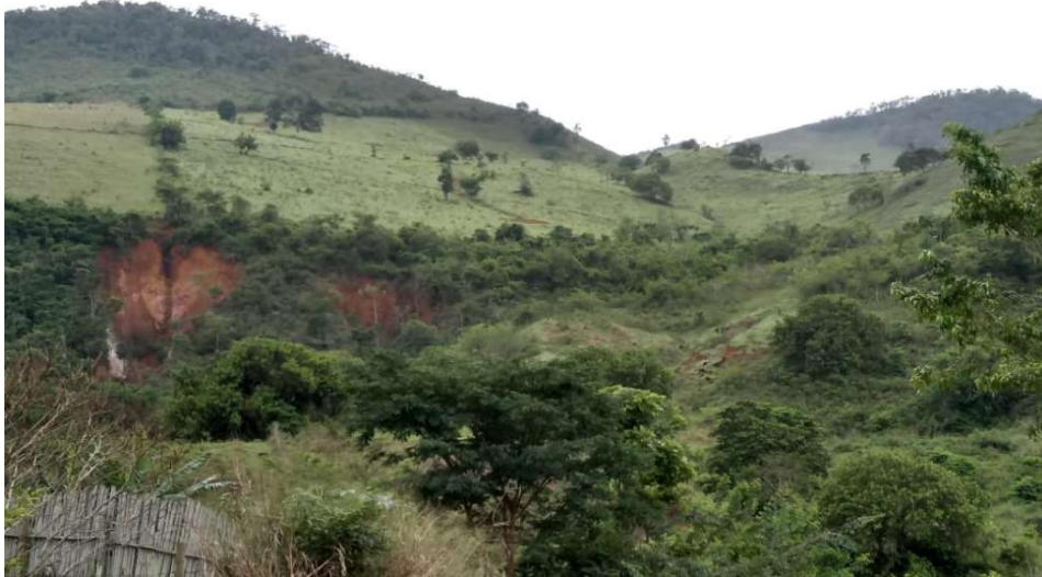
Figura 25: Erosão ocasionada pela remoção da vegetação associada às intempéries do clima no interior da APA Miragaia. Fonte: Acervo técnico DRM Engenharia e Meio Ambiente.
